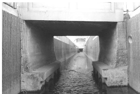
谷沢川 櫻橋上流側
