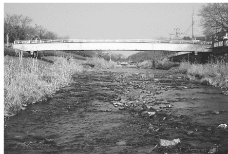
野川 神明橋上流側
