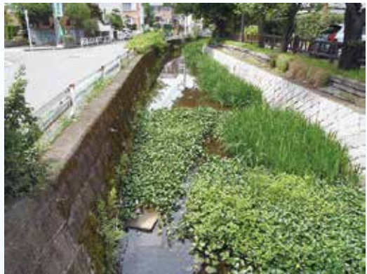
【根河原橋上流側】
