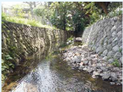
【紅葉橋下流側】
