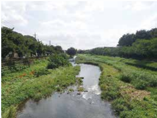
【神明橋下流側】
