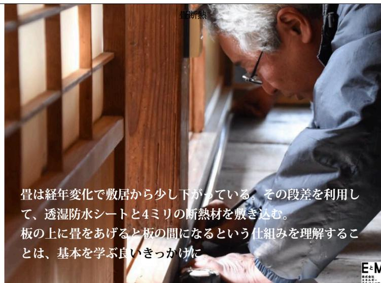
畳は経年変化で敷居から少し下がっている。その段差を利用して、透湿防水シートと4ミリの断熱材を敷き込む。板の上に畳をあげると板の間になるという仕組みを理解することは、基本を学ぶ良いきっかけ。
