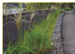
商業施設の屋上に整備した草地
