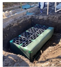
根系を誘導する貯留構造体
