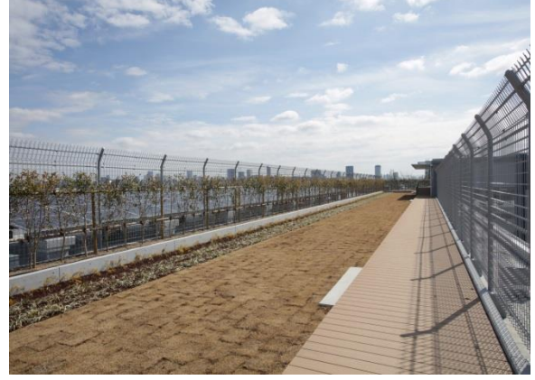
△下北沢小学校の屋上緑化
