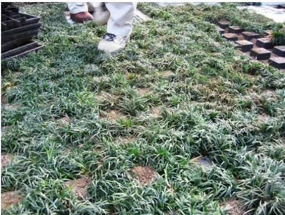
△城山駐車場の駐車場緑化(タマリユウ)
