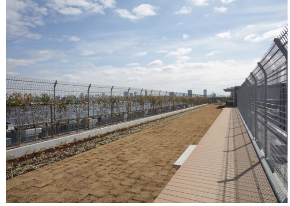
△下北沢小学校の屋上緑化
