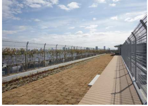
下北沢小学校の屋上緑化
