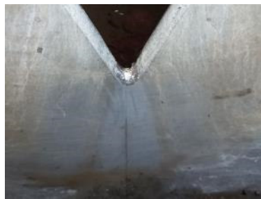
三角堰の越流無し(枯渇) (令和8年1月16日)
