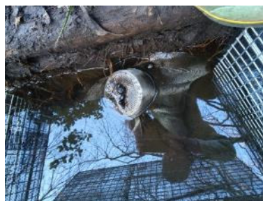
修繕後の循環ポンプ取水口 (令和8年2月6日)
