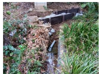
修繕後の循環ポンプ放水口 と放水状況 (令和8年3月6日)
