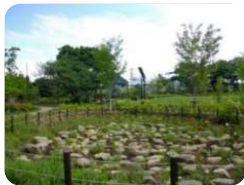
雨水を貯留して地下に浸透させる レインガーデン(上用賀公園)
