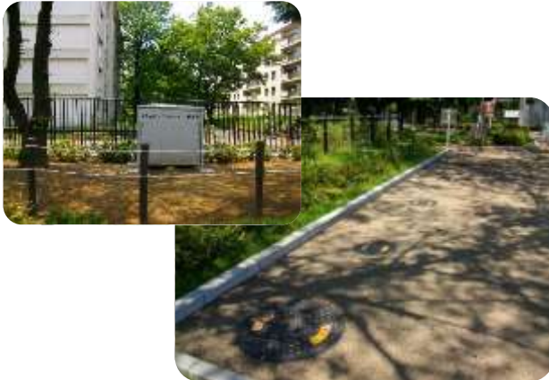
災害時に使用できるマンホールトイレと収納庫 (上用賀公園)
