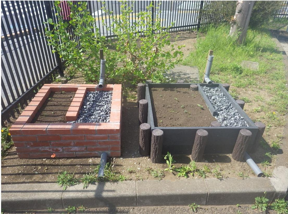
図 4.50 雨花壇の施工例(雨どいはモデル)
