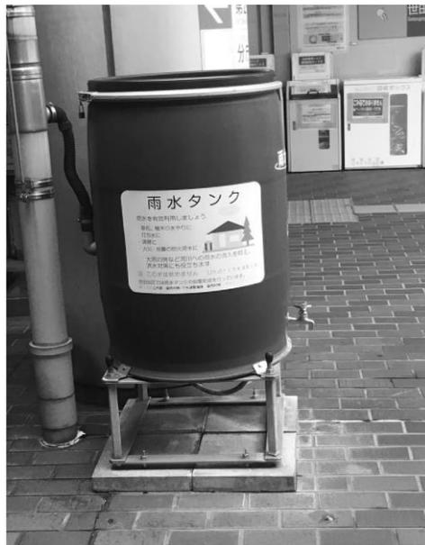
図 4.14 雨水タンクによる雨水貯留(各戸貯留対策)
