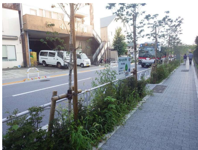
道路の植栽帯を活用した貯留浸透 透水性インターロッキングブロック
