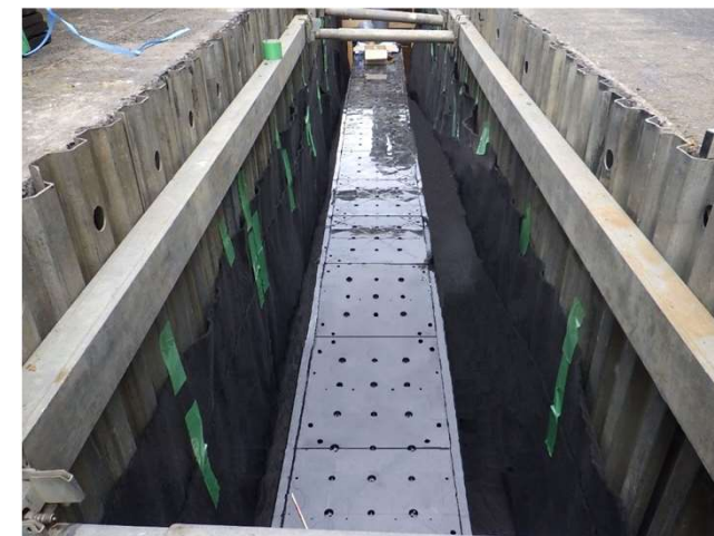
道路の地下貯留浸透槽
