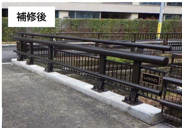
防護柵の取替
