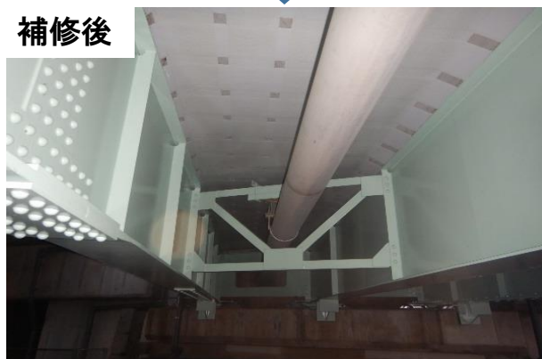
塗装の塗替 床版補強
