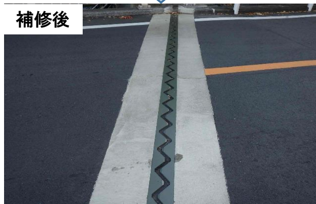
伸縮装置の補修
