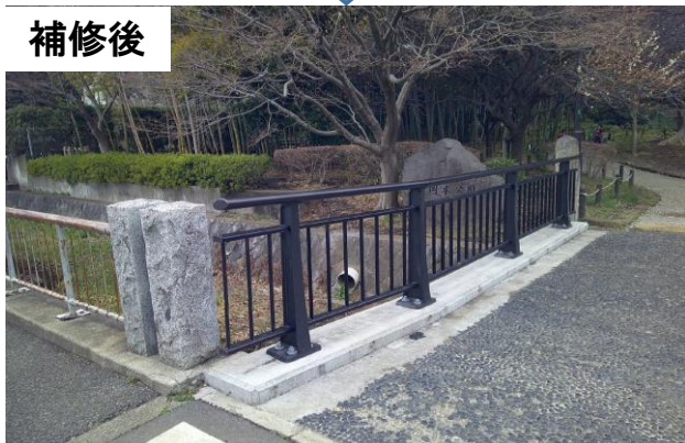
高欄の取替工
