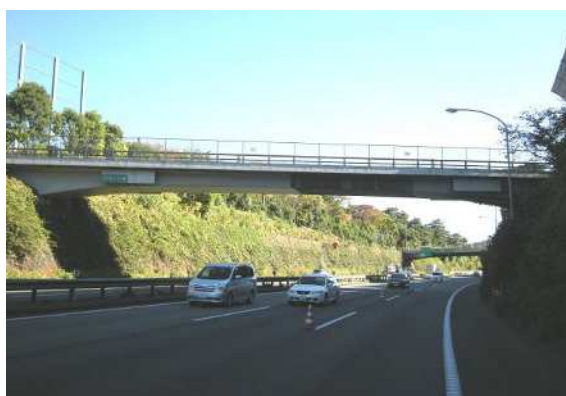
写真 2 - 7 道路（グランド橋）
