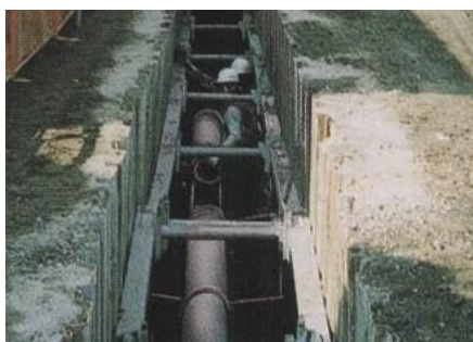
排水管設置状況
