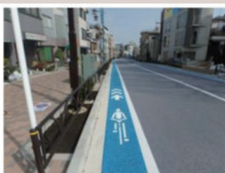
自転車走行帯（ブルーゾーン）
