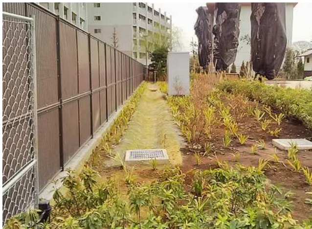
緑溝（芝張側溝）
