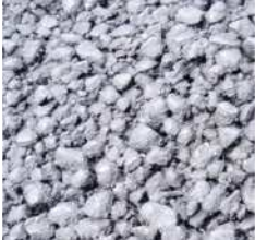
透水性舗装の表面
