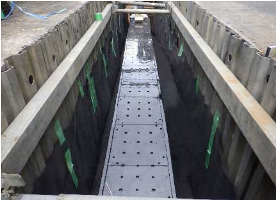
プラスチック製地下貯留浸透槽
