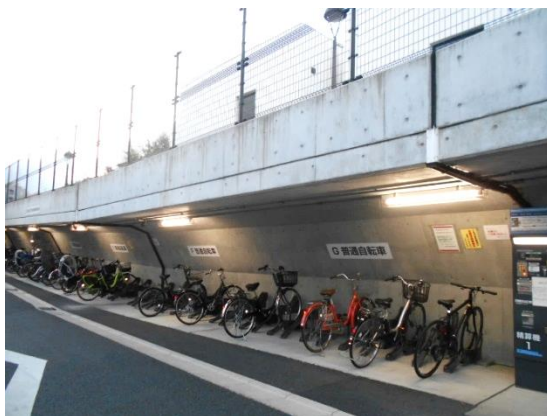
図 4-9 歩行者用通路下の空間を活用した駐輪場 (下北沢東自転車等駐車場)
