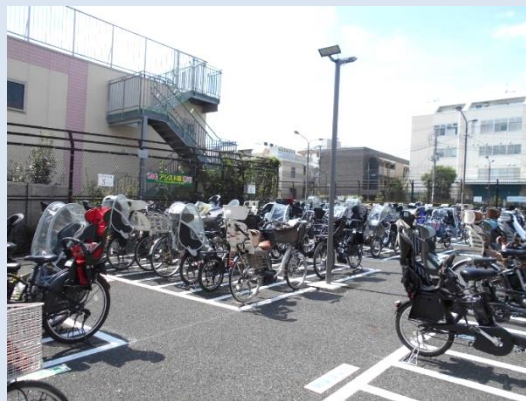
大型自転車専用スペースの設置（下北沢自転車等駐車場）
