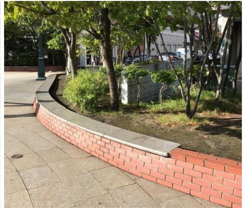
植栽柵の縁に座れる座面を設置することで、ひと休みできる空間ができます。座面の寸法は、高さが400~500mm程度、奥行きが300mm程度で、座面は温かみのある素材が望ましいです。また、植栽は座る場に干渉しない計画とします。
