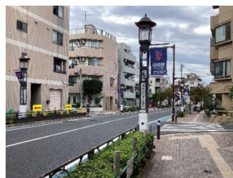
商店街施設整備事業への助成の活用例
