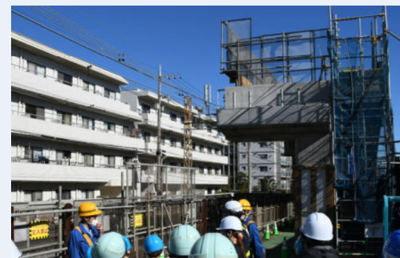
高架化工事状況
