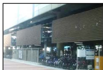
高架下利用のイメージ (駐輪場の事例:大田区糞谷)
