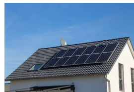
太陽光パネル
