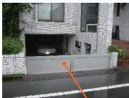
止水板の設置
