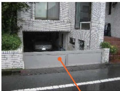
止水板の設置
