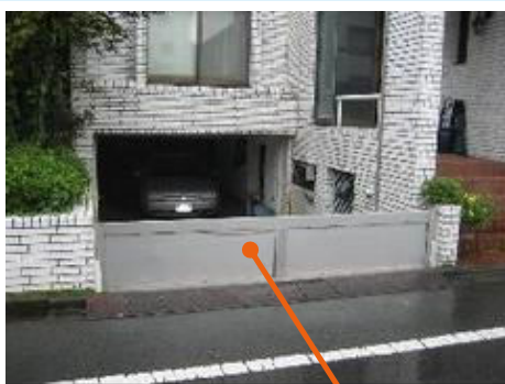
止水板の設置
