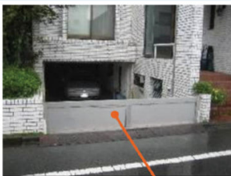
止水板の設置
