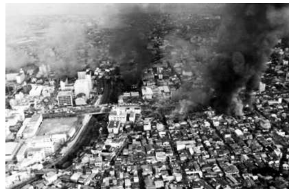
火災の延焼による被害 (平成7年1月 阪神淡路大震災)
