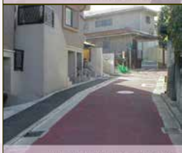
地区防災施設1号の片側拡幅 (2.7m→4.35m)
