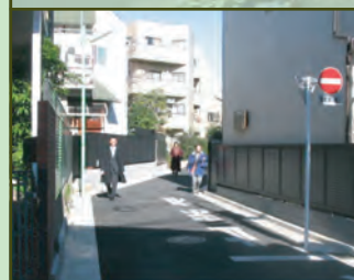
通り抜け道路の整備
