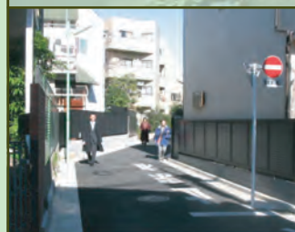
通り抜け道路の整備
