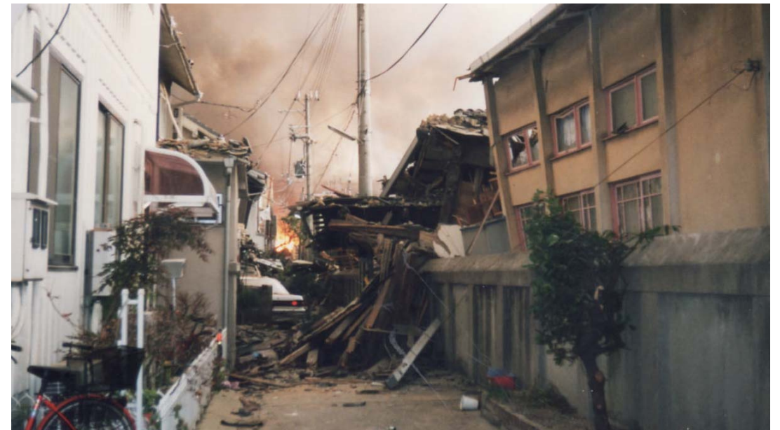
阪神・淡路大震災の被災の様子 (写真提供：神戸市)
