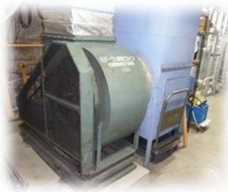
機械室給排気ファンは連続運転で運用していましたが、温度による自動運転・停止を行えるよう温度計を設置し、必要に応じたファンの運用を可能としました。
