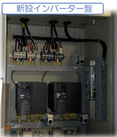
空調設備用熱源 1次ポンプにインバーターを新設し、流量調整で回転数を落とすことで、ポンプの搬送動力を低減しました。
