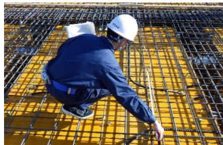
検査員による中間検査の様子
