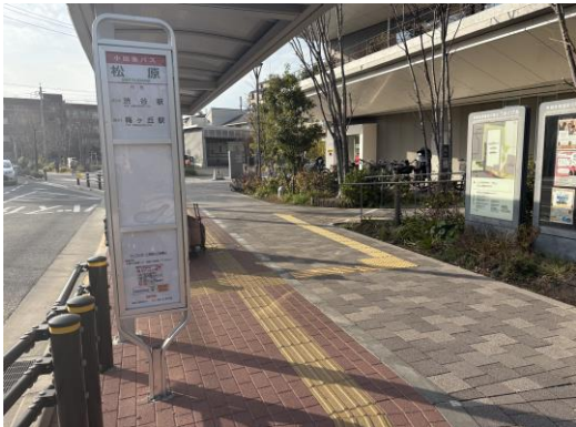
歩道と施設の敷地の段差解消 連続した誘導用ブロックの敷設 (梅ヶ丘駅周辺)
