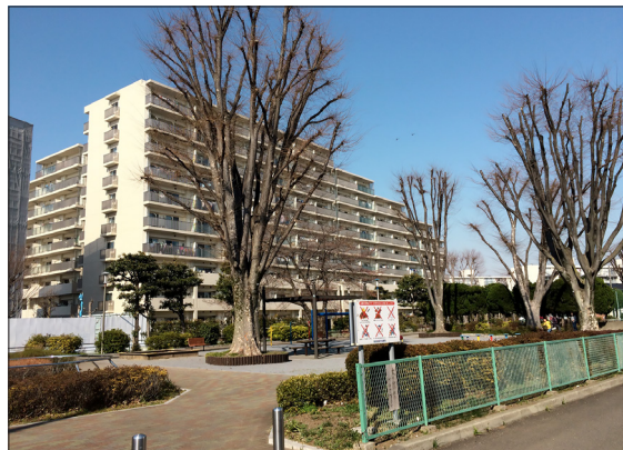
北烏山二丁目北部地区の街なみ (良好な住環境の保全のため、一団地の 住宅施設を廃止し、地区計画を策定)
