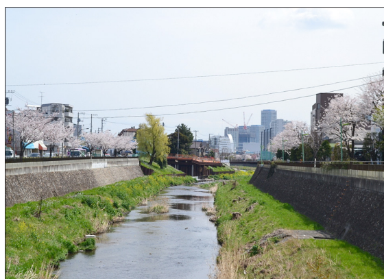
野川（河川改修後）
