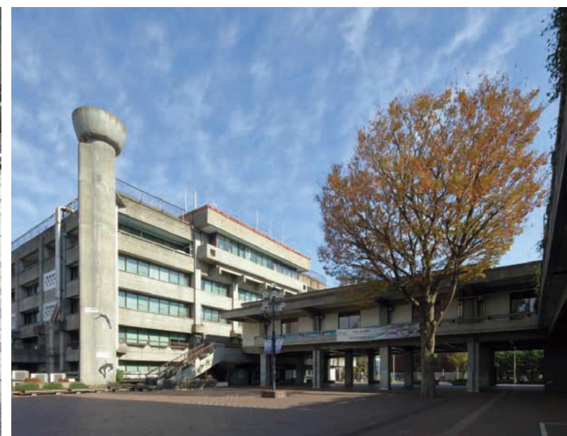
解体前の旧庁舎の様子(撮影:清水襄)
