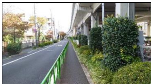
小田急小田原線高架橋側道脇 (出典=世田谷区 HP)
