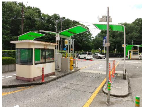
大蔵第二駐車場の入退場ゲート
