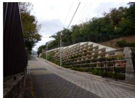
工事完了後 (野毛二丁目緑地)
