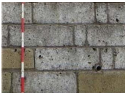
大谷石積み擁壁
