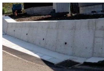
重力式コンクリート擁壁
