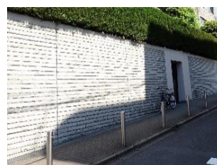
鉄筋コンクリート擁壁 擁壁表面にタイルを貼った例
