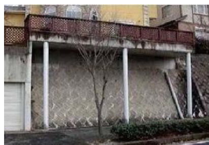
張出し床版付擁壁
