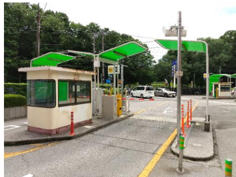
大蔵第二駐車場の入退場ゲート
