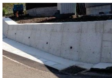
重力式コンクリート擁壁
