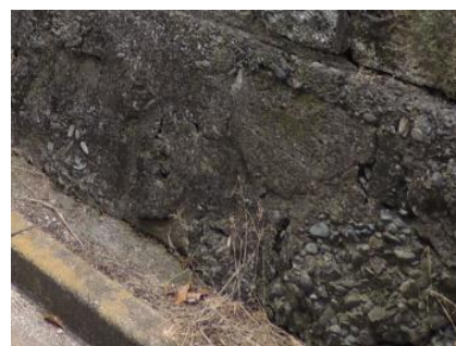
ガンタ積み擁壁
