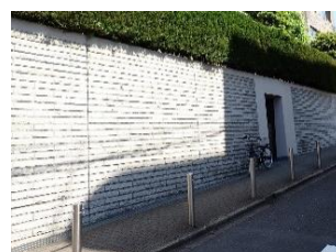
鉄筋コンクリート擁壁 擁壁表面にタイルを貼った例
