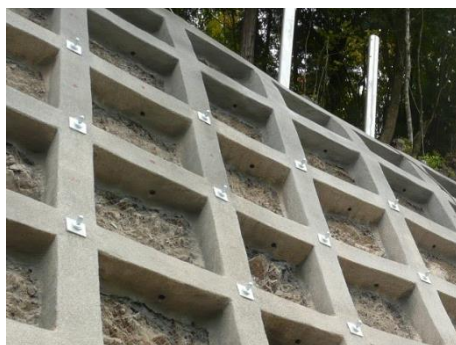
法面保護の施工例
