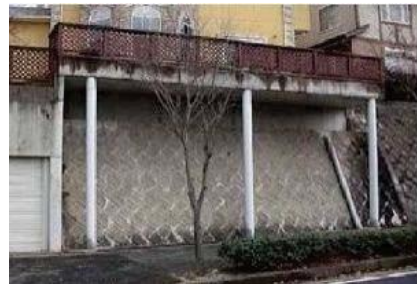
張出し床版付擁壁
