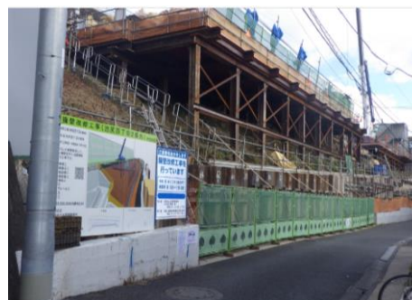
工事中 (令和7年12月現在)
