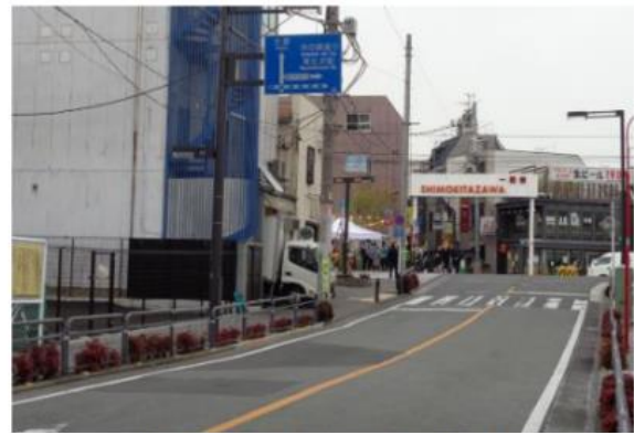
立体交差後の状況 (地下化前の小田急線下北沢駅付近)
