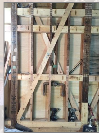
筋違いや構造用合板を使って補強
