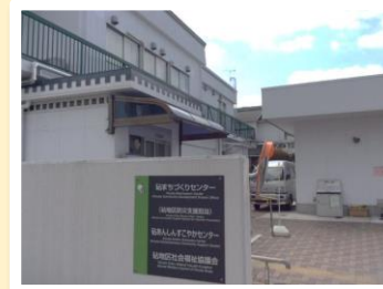
砦まちづくりセンターの外観
