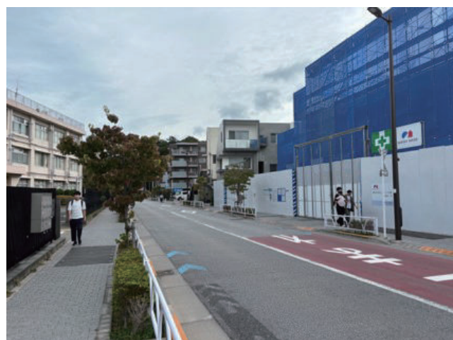
世区街第 7 号線 (I 期) (令和元年度 (2019 年度) 事業完了)
