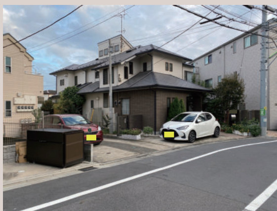
法定外公共物を活用した地先道路の整備事例
