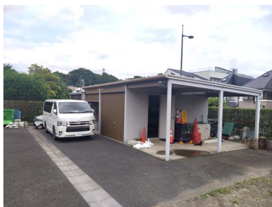
公園管理施設(二子玉川公園)
