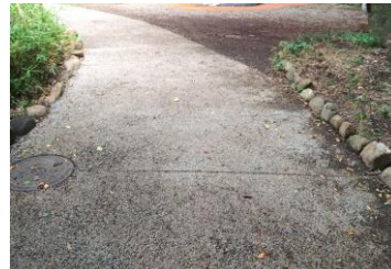
透水性舗装(岡本公園)
