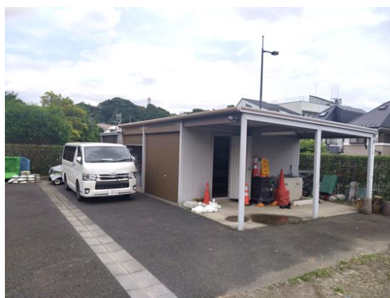
公園管理施設(二子玉川公園)
