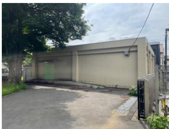
広域用防災倉庫(世田谷四丁目)
